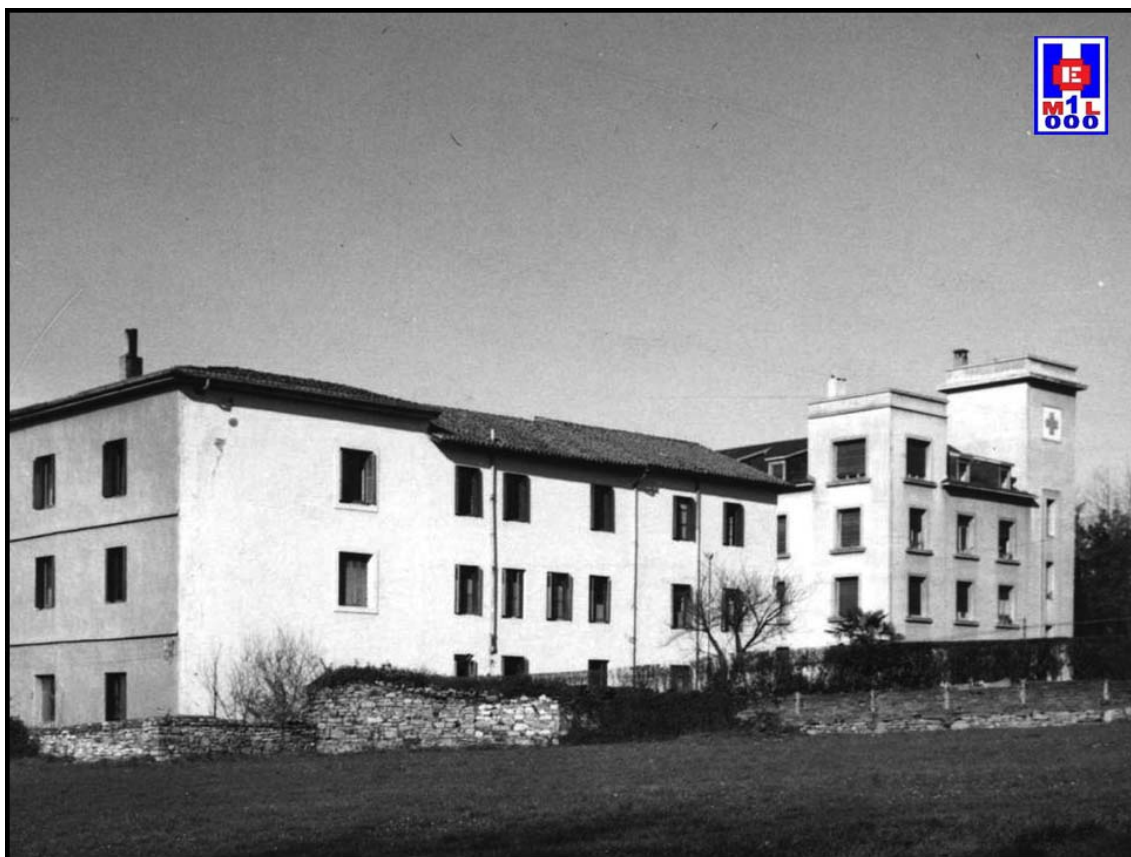
Foto 33 Casa, Colegio y Hospital de la Cruz Roja. La ampliación de los años 40 definió la estructura actual, aunque luego llegaron nuevas modificaciones. Archivo Municipal de Irún. Número 25695
